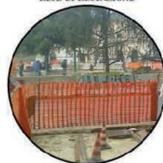
ESEMPIO DI RECINZIONE CANTIERE
