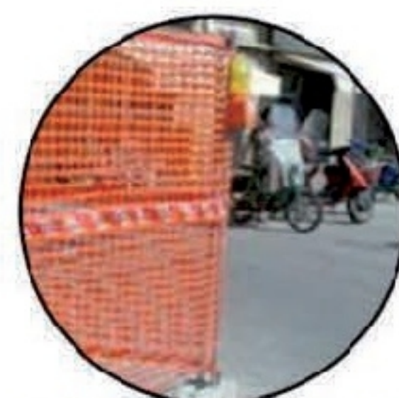
ESEMPIO DI RECINZIONE CANTIERE
