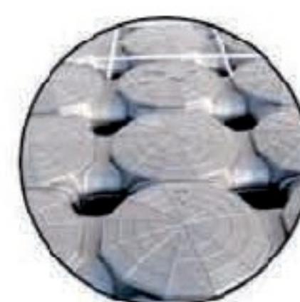
POSA RETE ELETTROSALDATA PER L'ESECUZIONE DEL SOLAIO
